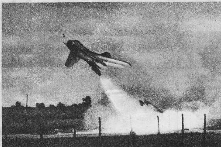
Самолет-аналог, созданный на базе истребителя МиГ-21 для изучения особенностей аэродинамической компоновки самолета Ту-144
